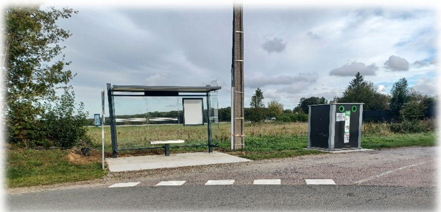
Changement de destination de l'abribus de Gournay + confection dalle pour la pose du container à verres
