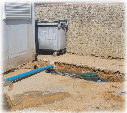
Installation d'une fosse toutes eaux
