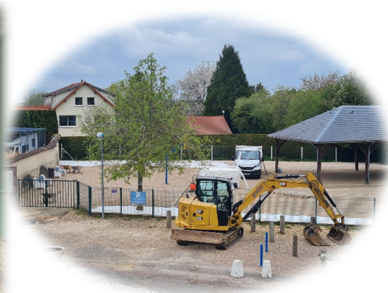
Réfection de la cour de l'école
